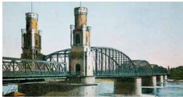
Die gewaltige Eisenbahnbrücke über die Weichsel bei Thorn/Torun.
